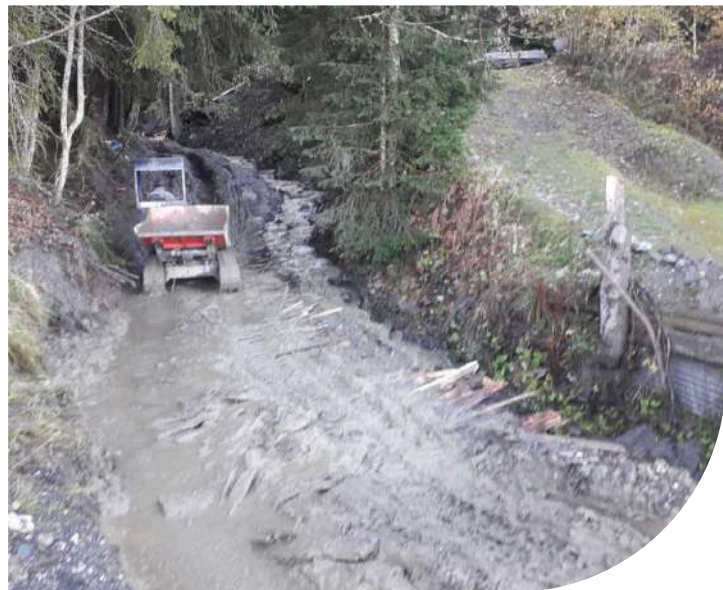
Curage du ruisseau du Tour (Megève)
