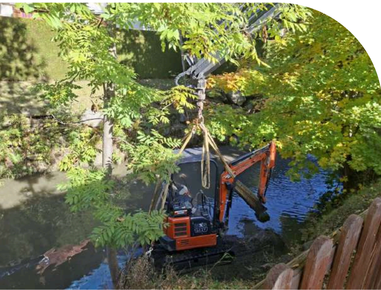
Curage du bac palais des sports Megève
