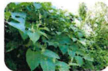
Travaux de lutte contre la propagation des espèces invasives
