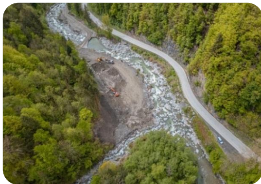
Travaux de terrassement de la rive gauche et restauration de l'espace de dépôt de matériaux en cas de crue du Nant Bruyant
