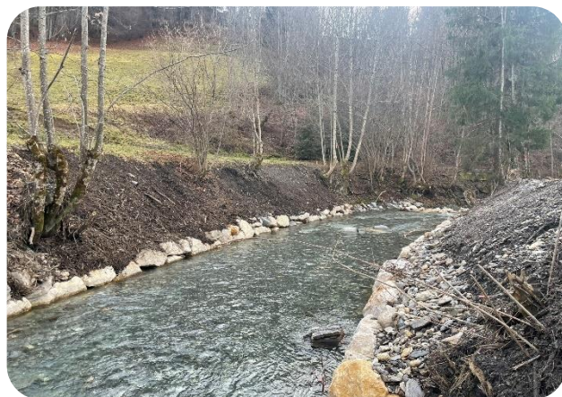
Travaux de purge des berges des déchets et de confortement en pied de berge
