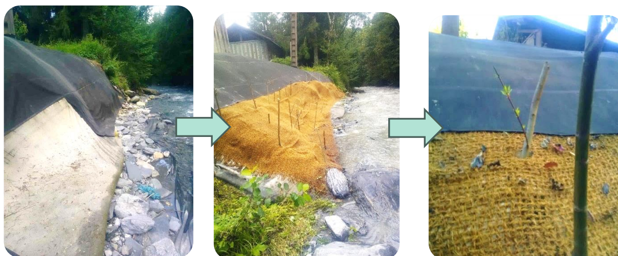
Nov. 2023 : bâche endommagée par la crue sur la partie aval
