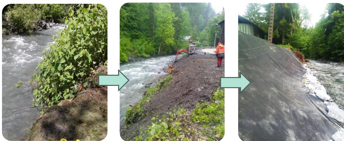
Arrachage du massif, retalutage en pente douce puis bâchage de la berge en 2021.
