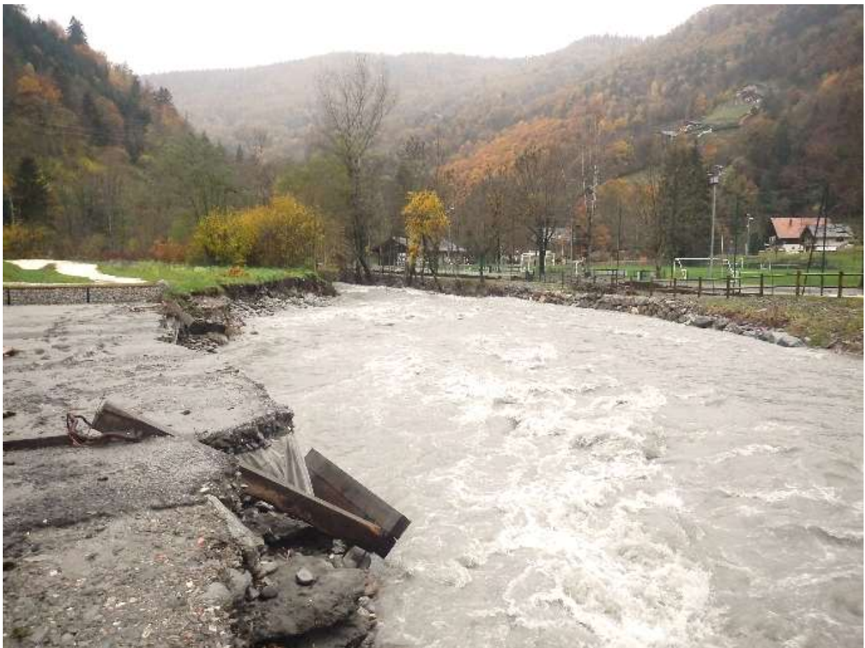
Erosion de berges du Doron sur la base de loisirs de Queige
