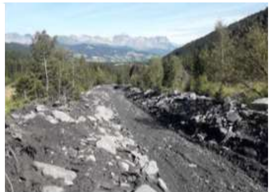
Recalibrage du lit d'un affluent du Glapet – avant et après travaux
