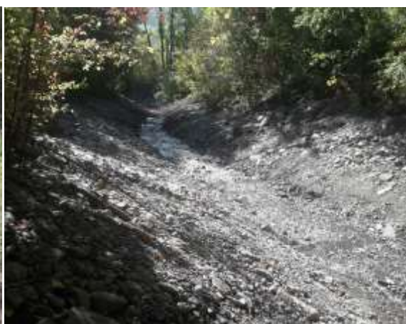
Chenal recalibré après travaux
