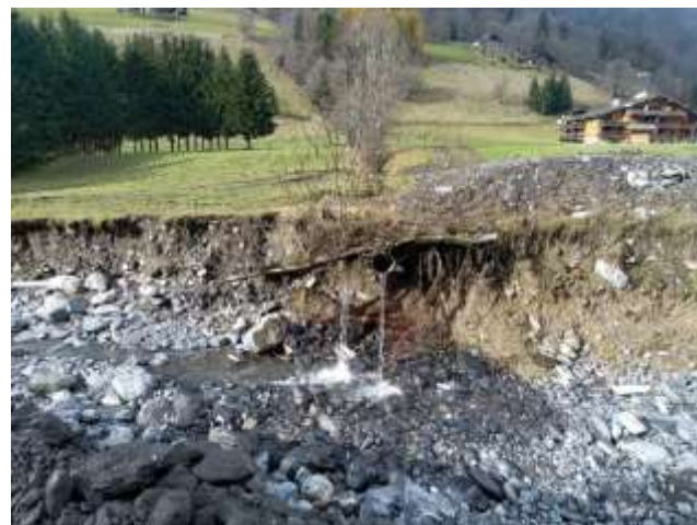
Divagation de l'Arrondine au Plan sur la commune de la Giettaz, érosion de berge arrachant le réseau d'assainissement
