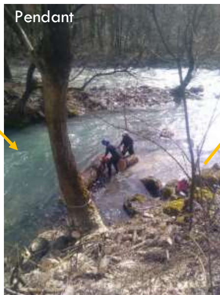
Enlèvement d'un embâcle dans la Chaise
