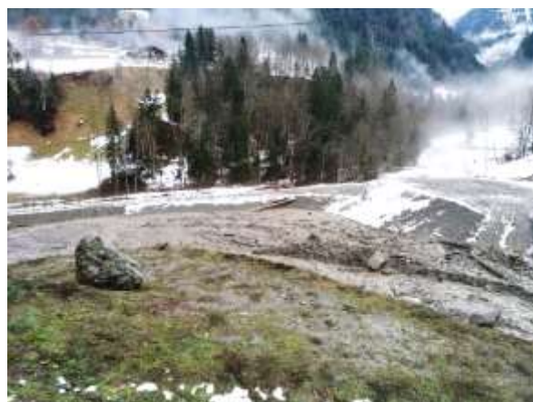
Obstruction du dallot de la RD925 par le torrent du Bersend à Beaufort
