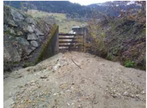
Engrèvement de la plage de dépôt du torrent des Carroz, situé à Arêches sur la commune de Beaufort (avant et après la crue)
