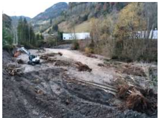
Erosions de berges de l'Arly, en aval du pont de Cassioz – travaux de recalibrage et enlèvement embâcles (SMBVA) à Praz sur Arly
