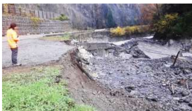
Gorges de l'Arly : glissement de terrains, érosions de berges et dommages à certains ouvrages de protection de la RD1212
