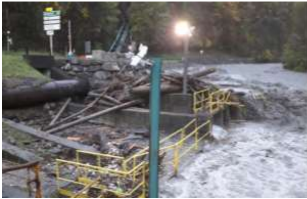
Engrèvement du lit de l'Arly aux Molières à Ugine (aval des gorges) – travaux d'urgence pour limiter l'engrèvement au droit du seuil (SMBVA)
