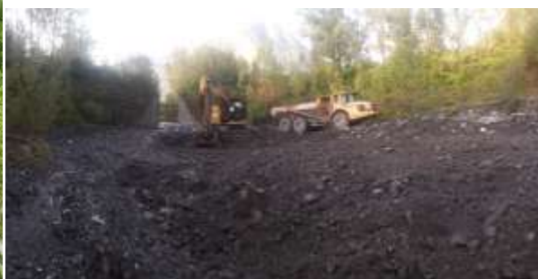
Curage de la plage de dépôt de Mont dessous
