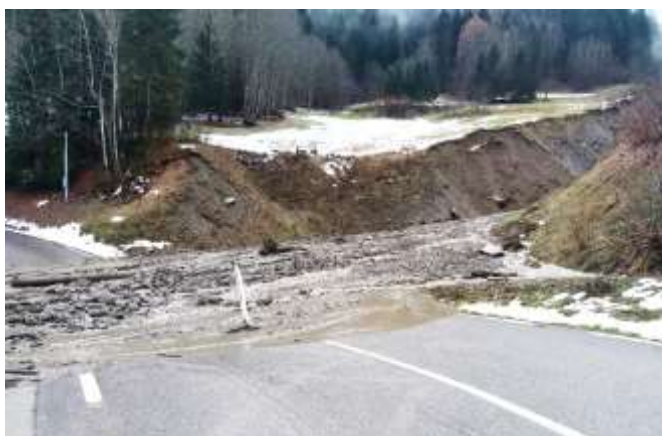
Obstruction du dallot de la RD925 par le torrent du Bersend à Beaufort
