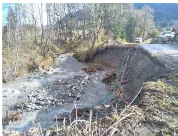
Torrent de Cassioz, érosion de berges et affouillement des réseaux à Megève
