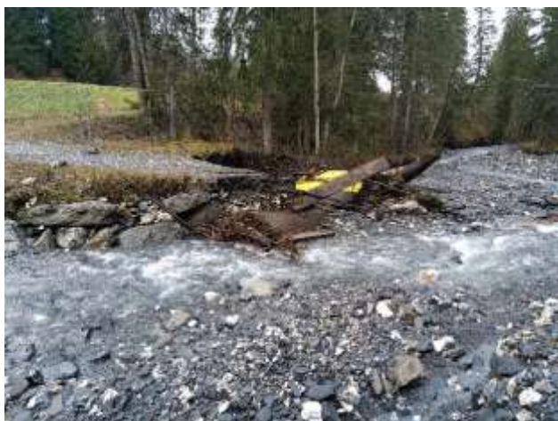
Torrent de Cassioz, érosion de berges et affouillement des réseaux à Megève
