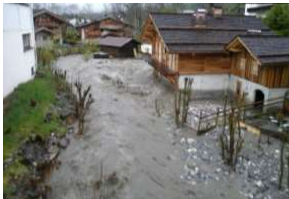
Débordement du Glapet le 1 er mai 2015
