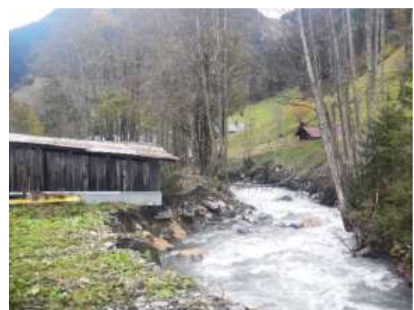
Erosion Argentine au droit du glissement de Crêt Bron - Beaufort
