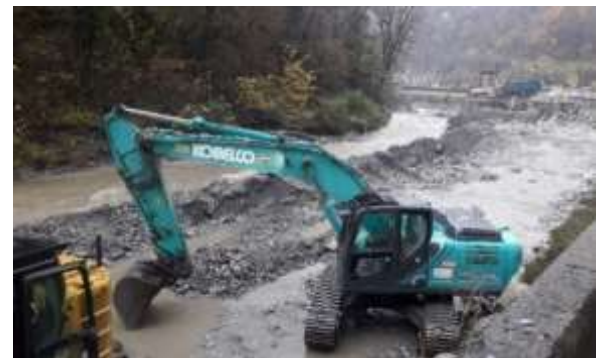
Engrèvement du lit de l'Arly aux Molières à Ugine (aval des gorges) – travaux d'urgence pour limiter l'engrèvement au droit du seuil (SMBVA)
