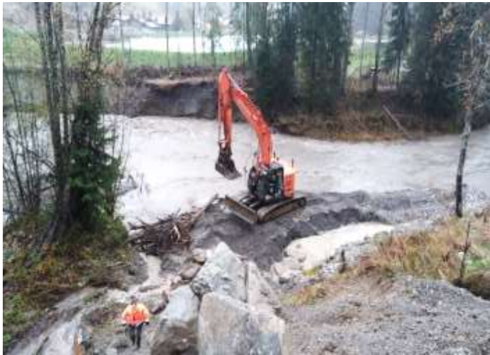
Erosions de berges de l'Arly, en aval du pont de Cassioz – travaux de recalibrage et enlèvement embâcles (SMBVA) à Praz sur Arly
