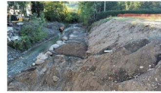
Travaux de terrassement sur le canal de l'Arly à Prévessin-Arly. Photo SMBVA
