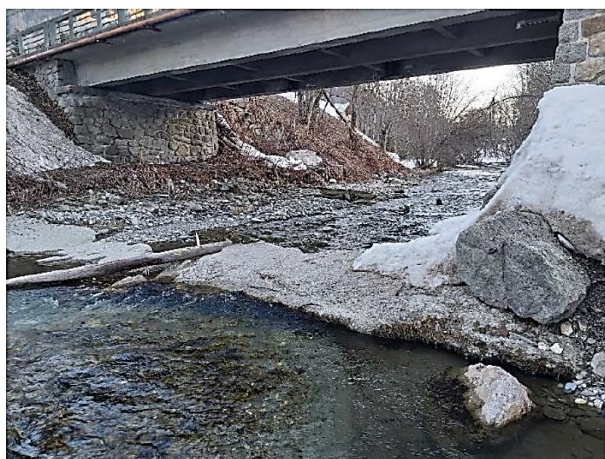
Figure 3 : Seuil en février 2022 avec affouillement et siphon (Photo SMBVA)
