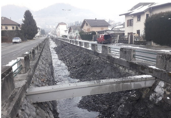
Entretien sédimentaire du canal du Nant Pugin à Uge
