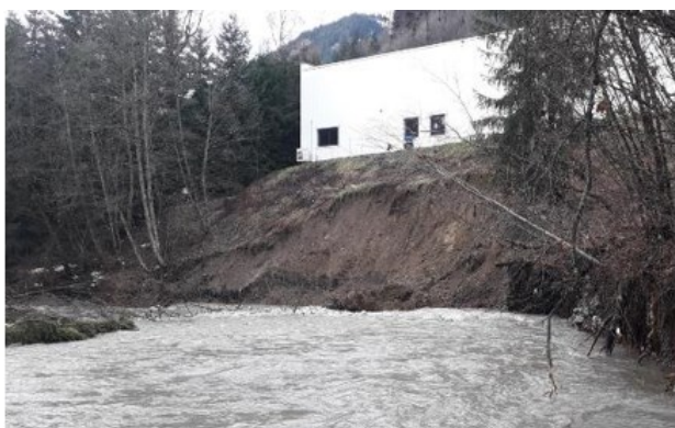
Erosion de berges de l'Arly à Praz sur Arly
