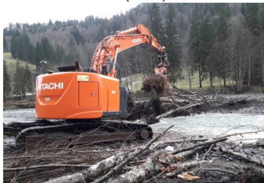
Travaux d'enlèvement des embâcles et bois sur l'Arrondine aux Glières (SMBVA)
