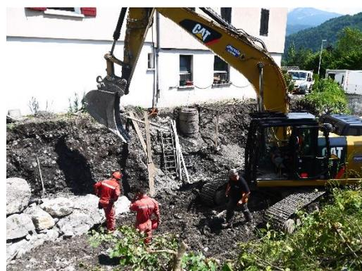
La protection de berge a été déposée puis reconstruite sur un sabot anti-affouillement. Un seuil de calage a aussi été créé afin de caler le fond du lit du torrent.
