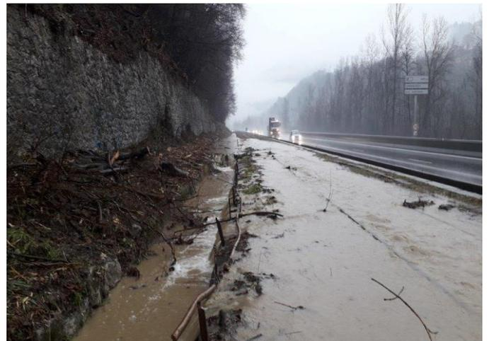
Obstruction du canal Lallier sur le secteur aval – canal sec drainant les affluents de Pallud, inondation de la voie ferrée et risques pour la RD1212
