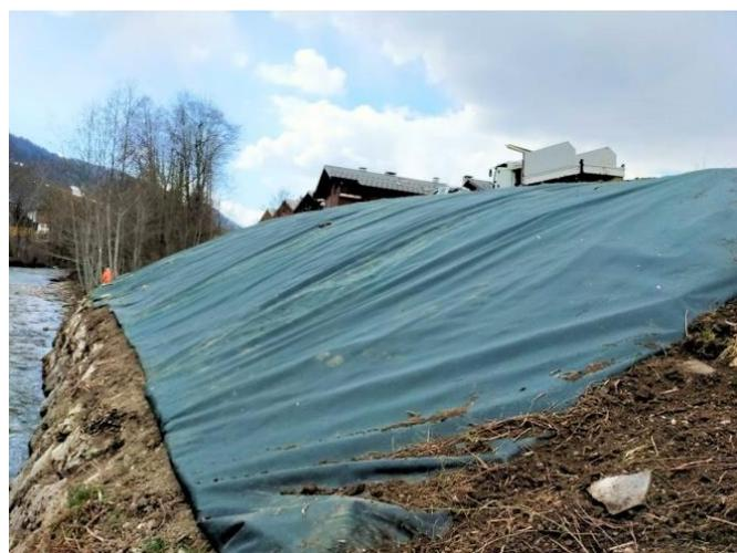
Cette opération vise à affaiblir le massif de renouée, par l'installation d'une géomembrane puis à le concurrencer avec d'autres espèces.
